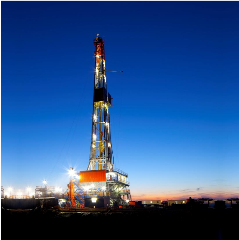
Буровая установка грузоподъемностью 200 тонн
